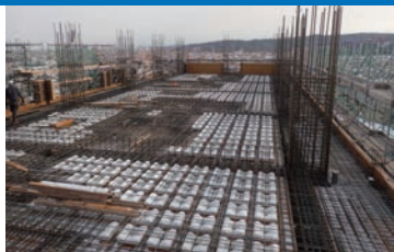
現場写真(H30年2月撮影)
